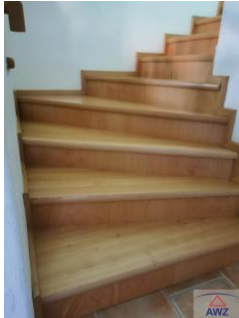
Treppe ins Obergeschoss
